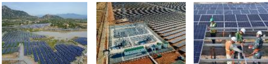
Nhà máy mặt trời địa bàn tỉnh Ninh Thuận
